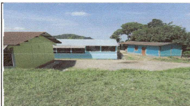
Foto 4: Sustitución de lámina por lámina troquelada aluzinc
