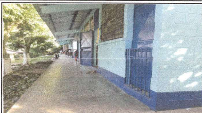
Foto 2: Pintura en muros exteriores e interiores
