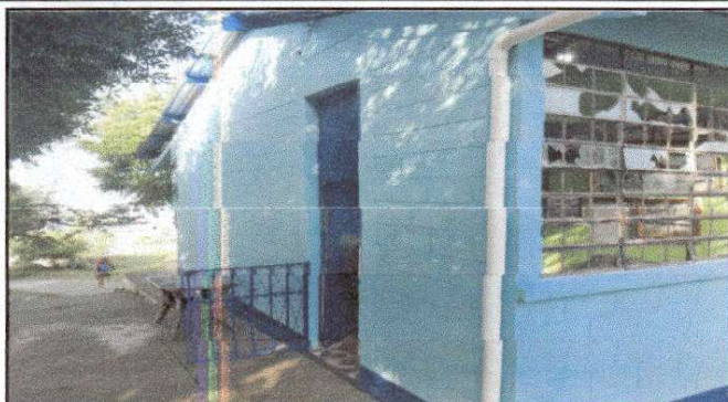
Foto1: Pintura en muros exteriores e interiores
